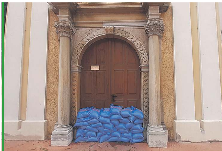
Proboszcz nakazał ułożenie worków przy drzwiach wejściowych, ale tym razem woda oszczędziła klasztor i kościół.
