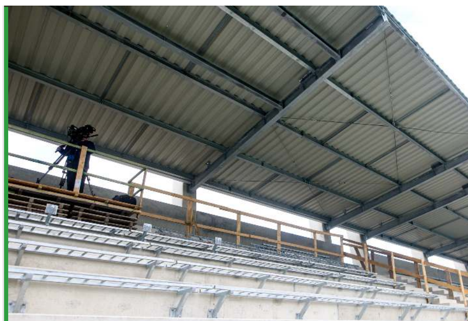
Zamontowano już zadaszenie na obiekcie Polonii.
